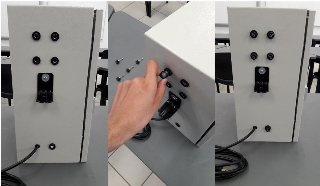
**Figura 36.** Colocación de los fusibles y de los porta fusibles, en el resto de los gabinetes.
