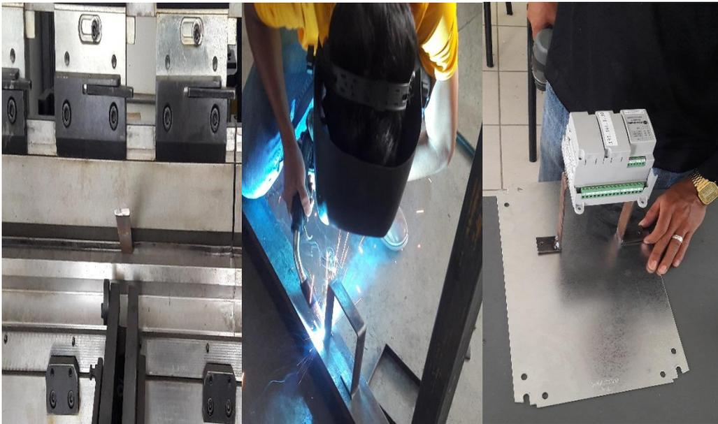
**Figura 35.** Elaboración y colocación de las bases para los PLCs, en el resto de los gabinetes.
